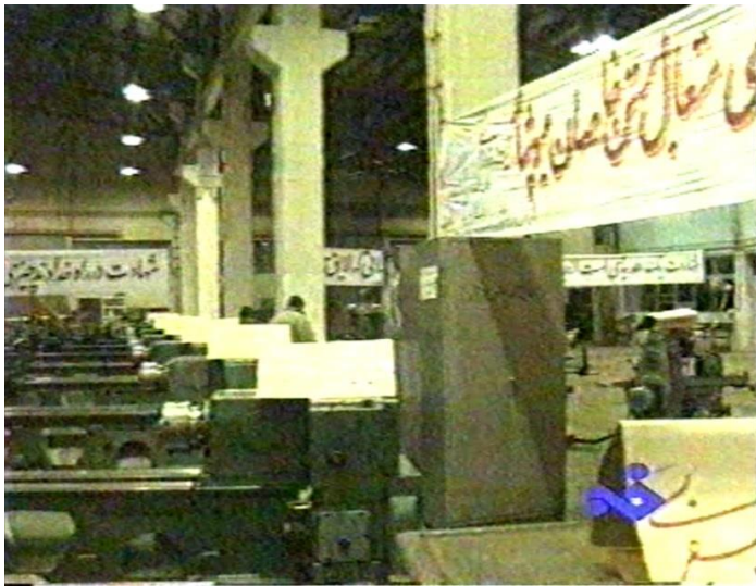
موقعیت ستون‌های وسط داخل کارگاه (بعد از بازسازی) تفاوت سازه سقف در تصویر بالا و پایین مشخص است.
